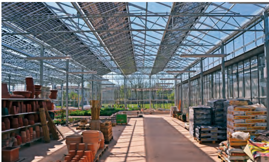
Foto 4 Le coperture fotovoltaiche per le serre sono più adatte alle zone di lavorazione-invasamento rispetto a quelle di produzione
