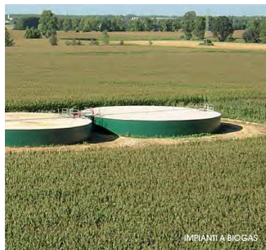
IMPIANTI A BIOGAS
