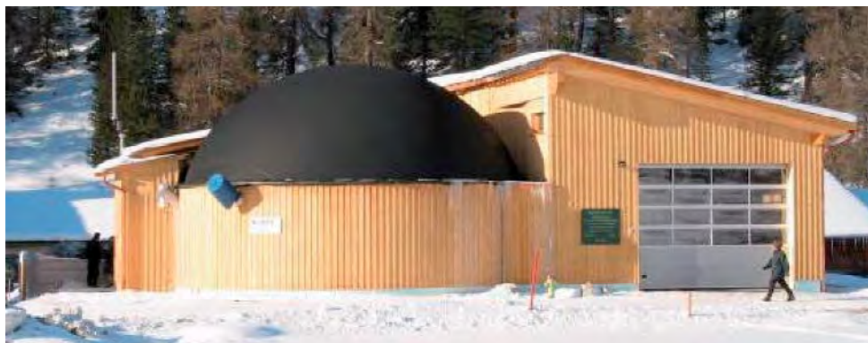
St. Moritz, pot. elettrica installata: 100 kw: Impianto "Agrigas Gastro" per il trattamento degli avanzi di ristorazione turistica insieme con reflui allevamento di 30 capi bovini
