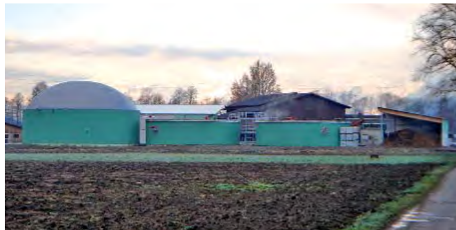
Widnau, pot. elettrica installata: 500 kw: impianto "Agrigas Communal" per il trattamento di FORSU, fanghi di depurazione, sottoprodotti da industria alimentare, residui manutenzione giardini, sfalci e potature
